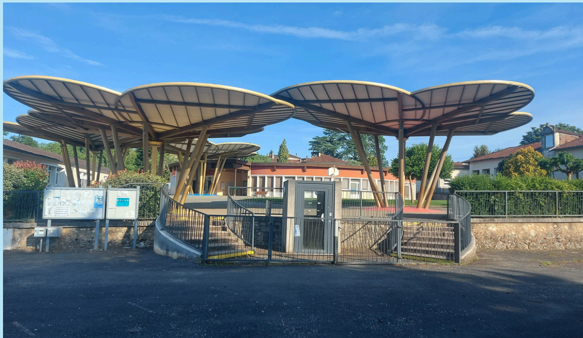
PORTAIL D'ENTRÉE DE L'ÉCOLE / COUR DU HAUT
