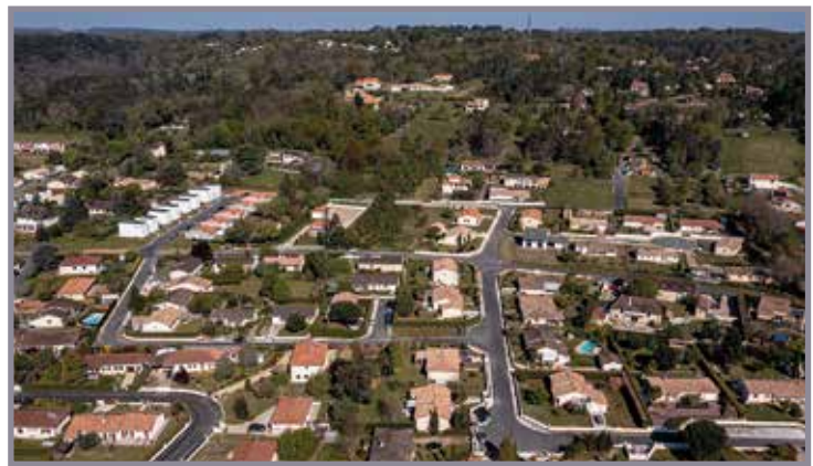
LA COMMUNE DE CHANCELADE POSSÈDE UN IMPORTANT RÉSEAU ROUTIER QUI EST APPELÉ À SE DÉVELOPPER DANS LES PROCHAINES ANNÉES VUE SUR LE QUARTIER DES COMBEAUX
